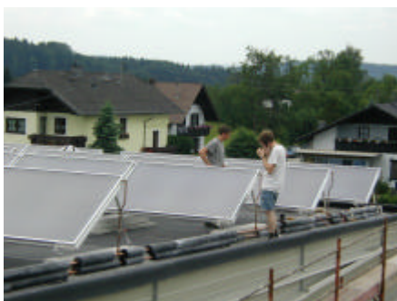
... Installation der Solaranlage ...
