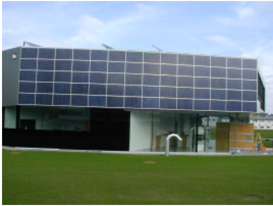
Fassadenkollektoren – Stromerzeugung mit der eigenen Photovoltaik-Anlage
